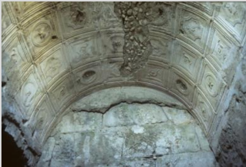
Voûte (in situ)
