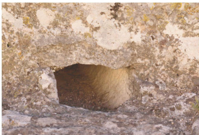
Fig. 272. Bouche ménagée dans le mur extérieur de la maison de Dionysos et d'Ulysse pour évacuer les eaux pluviales (cl. R. Selmi).
