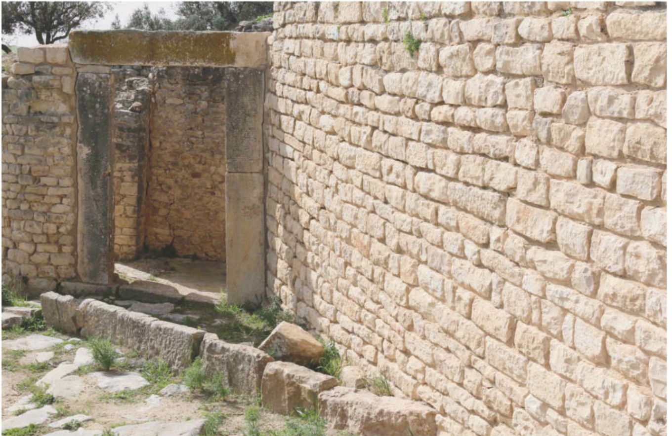
Fig. 271. Entrée de la maison du Canard et des Saisons ; à l'avant, barrière anti-inondation (cl. R. Selmi).
