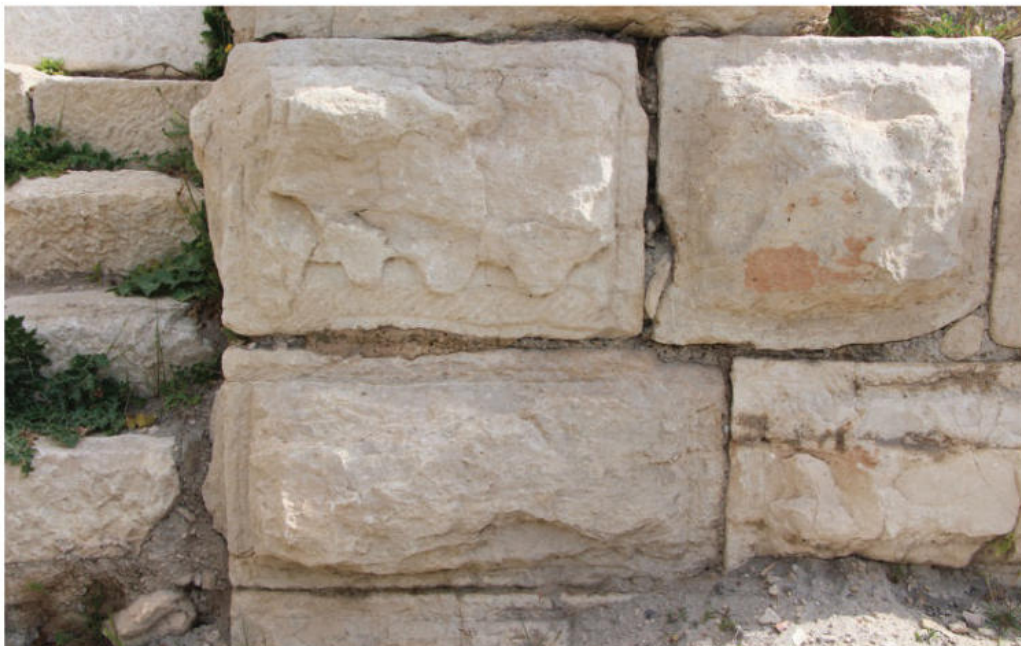
Fig. 11. Emboîtures de coins au fond d'une saignée sur un bloc mis en œuvre dans le soubassement de l'abside du sanctuaire dit Dar Lachhab (cl. Y. Maligorne, © INP/ AOROC).
