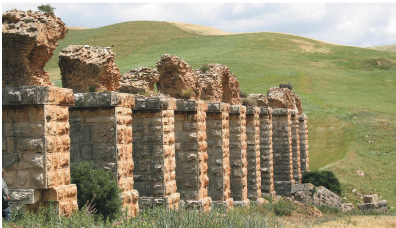
Fig. 136. Pont-aqueduc à conduite forcée au passage de l'oued El-Melah (cl. V. Brouquier-Reddé).
