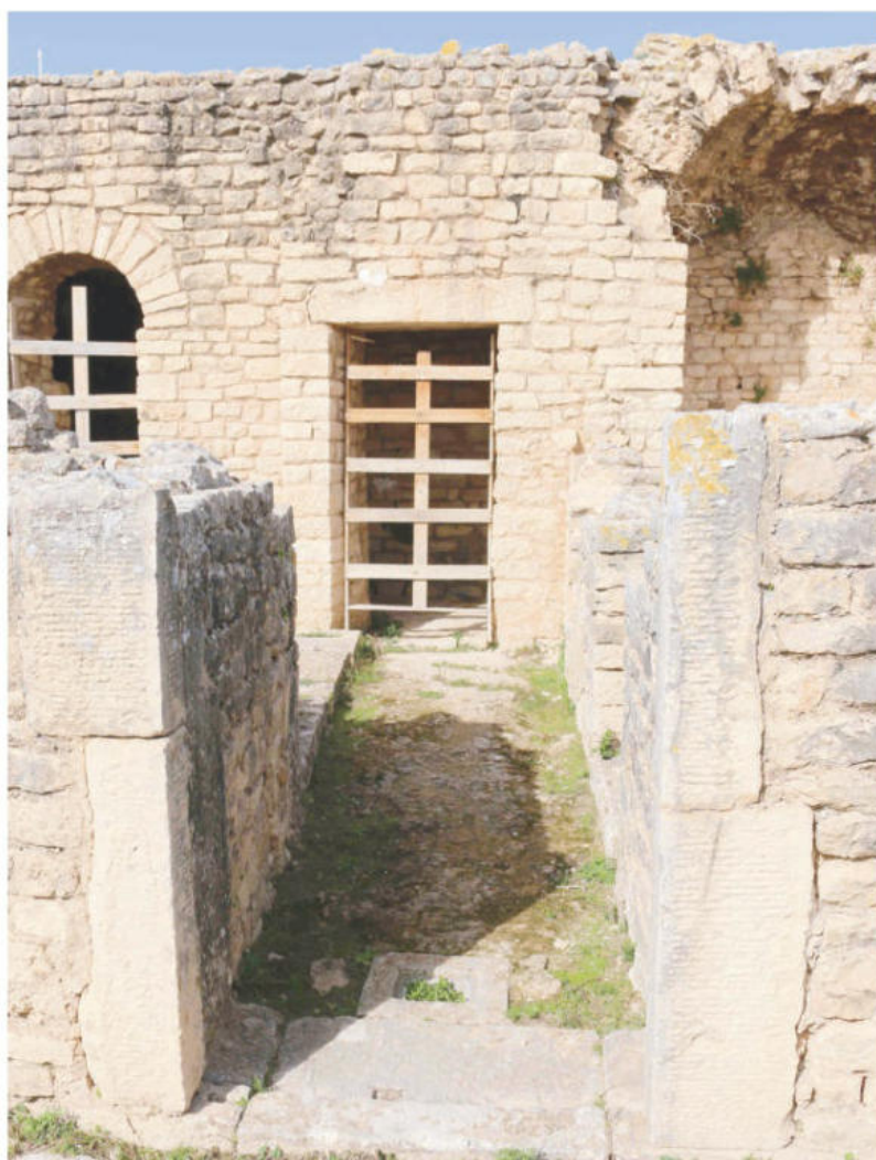
Fig. 284. Maison du Canard et des Saisons, entrée secondaire (cl. R. Selmi).
