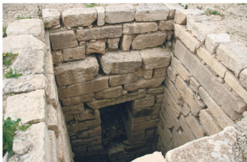
Fig. 348. Le grand puits à l'intérieur de la forteresse byzantine : le cuvelage en pierre et l'ouverture dans sa paroi occidentale
