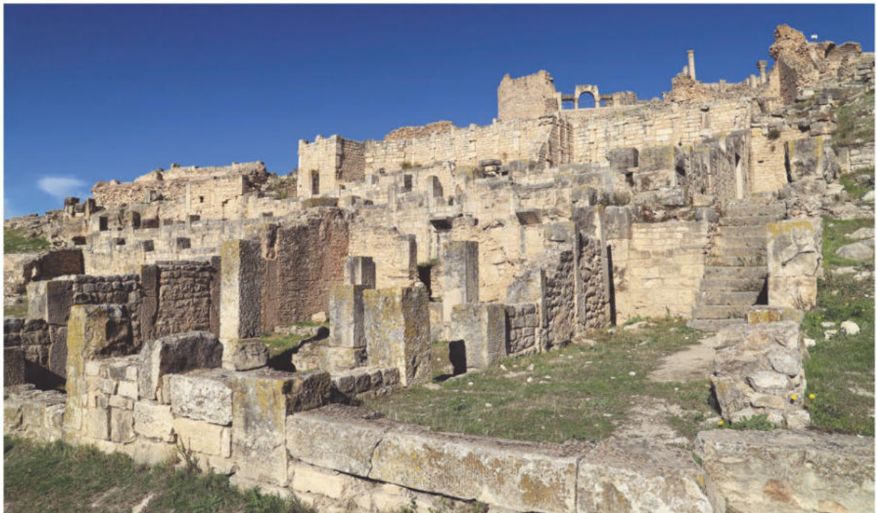
Fig. 268. L'escalier d'accès à l'étage de la maison des Trois Masques (cl. H. Abidi, © INP/ AOROC).
