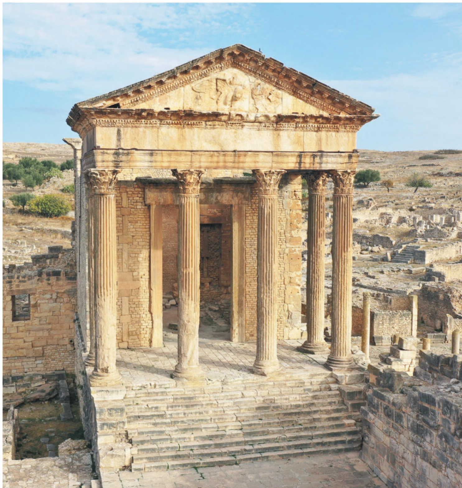
Fig. 118. Le capitole : la façade principale (prise de vue par drone en 2021, cl. H Kerkeni GeoArch, © INP/ AOROC).
