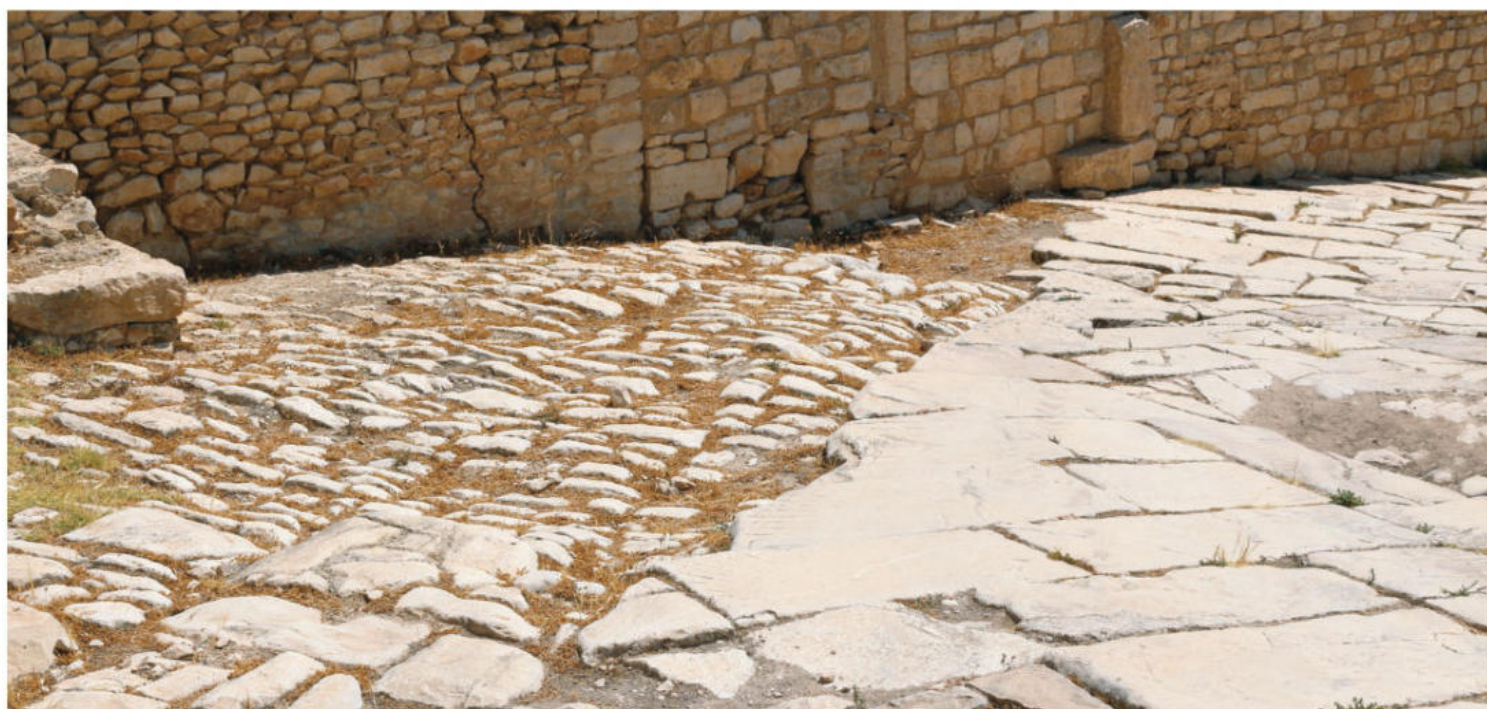
Fig. 99. La superposition des deux états de pavements dans la Grande rue Courbe (cl. A. Khéchine).
