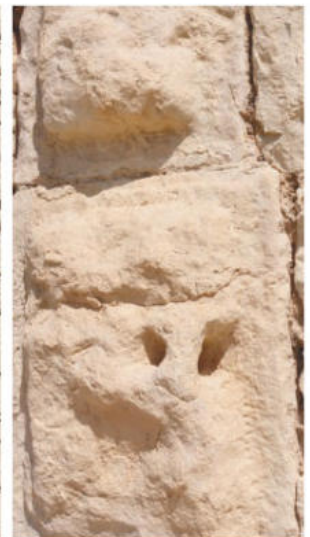
Fig. 309-310. Anneaux servant à attacher les bêtes de somme, pratiqués dans le bossage des harpes d'un mur en opus africanum , à l'entrée de service des thermes de Caracalla ; à droite, détail d'un anneau (cl. A. Khéchine).
