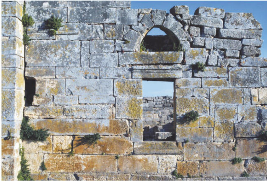
Fig. 352. La poterne nord de l'enceinte byzantine, surmontée d'un arc de décharge (cl. V. Brouquier-Reddé, © INP/AOROC).
