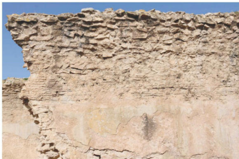
Fig. 302. Traces de roseaux sur l'intrados d'un des réservoirs d'Aïn Mizeb (cl. R. Selmi).
