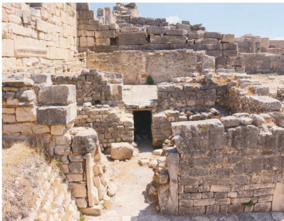
Fig. 358. Vue d'ensemble du hammam (cl. A. Khéchine).
