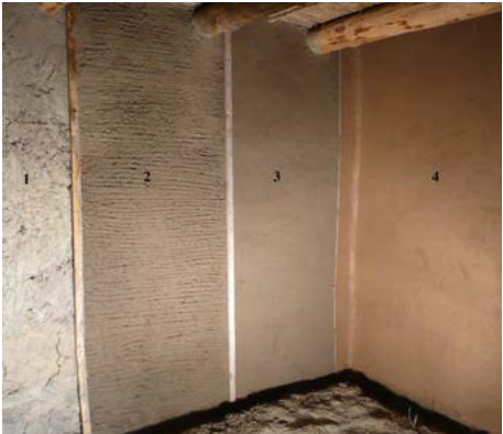
Fig. 2 : Lattes, chantier expérimental. 1. Mur en bauge. 2. Corps d’enduit. 3. Régularisation. 4. Décor (C.-A. de Chazelles).
